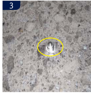
3 Læg vinyl hen over afløbet Lay out vinyl over the drain.
