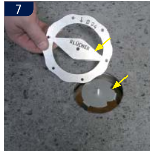
7 Placer skabelonen over indsatsen så fligene flugter og spænd skruen.
