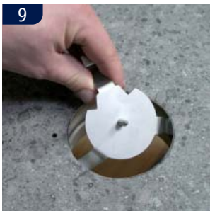
9 Tag indsatsen op Remove the insert.
